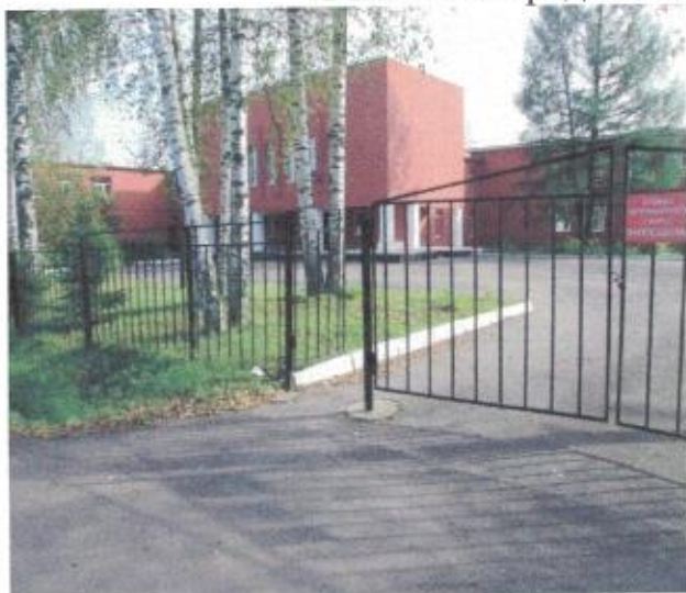
Фото №1 – Подходы к объекту
