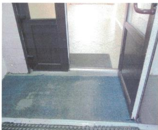
Фото №9 – Внутренняя входная дверь
