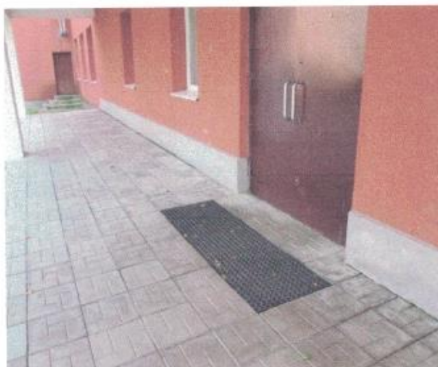
Фото №6 – Входная площадка главного входа
