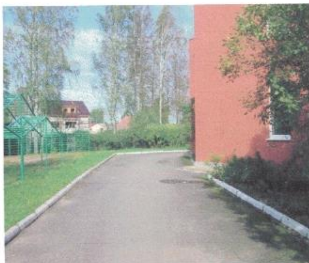
Фото №3 –Вход на прилегающую территорию
