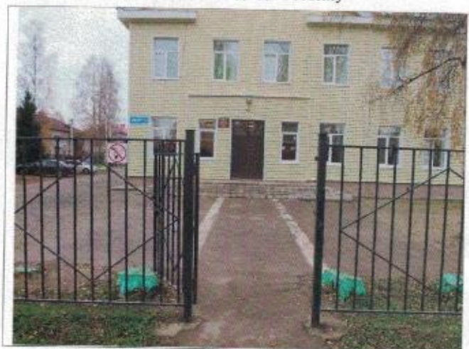
Фото №3 – Вход на прилегающую территорию
