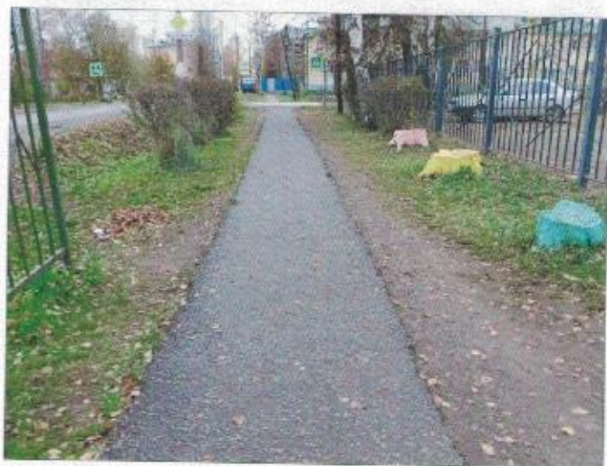
Фото №1 – Подходы к объекту
