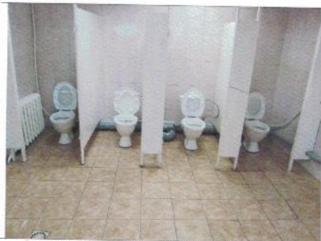
Фото №26 – Санитарно-гигиеническое помещение (туалетная кабина)
