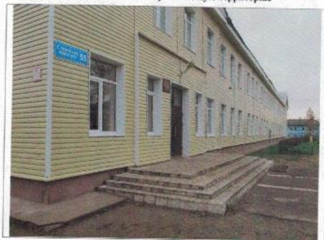
Фото №5 – Наружная лестница
