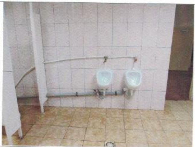
Фото №27 – Санитарно-гигиеническое помещение (писсуары)
