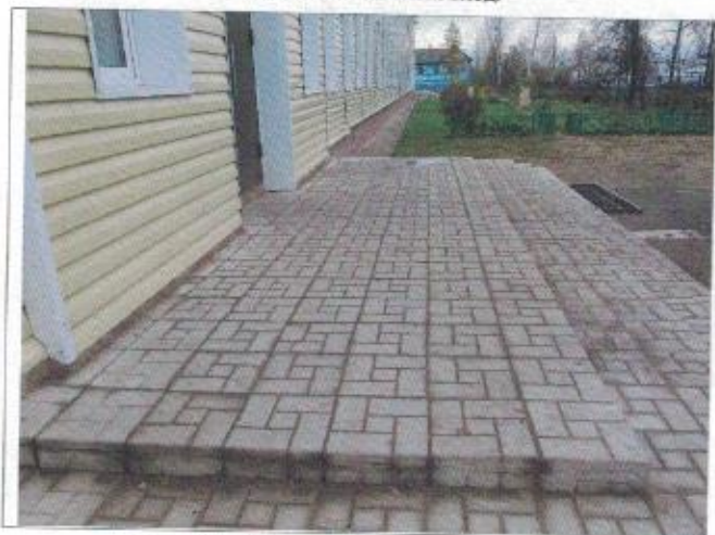
Фото №6 – Входная площадка главного входа
