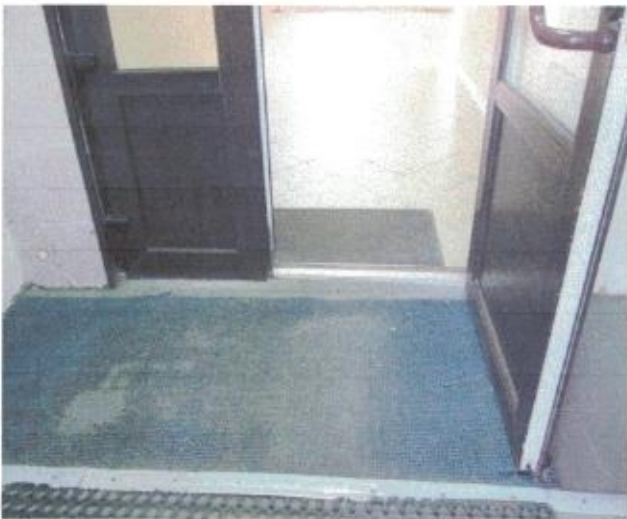
Фото №9 –Внутренняя входная дверь
