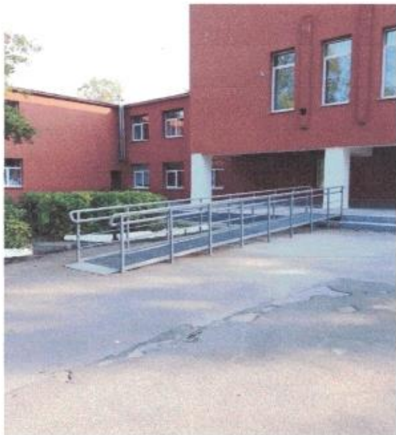
Фото № 1- организация прохода со стороны главного входа для граждан с ограниченными возможностями
