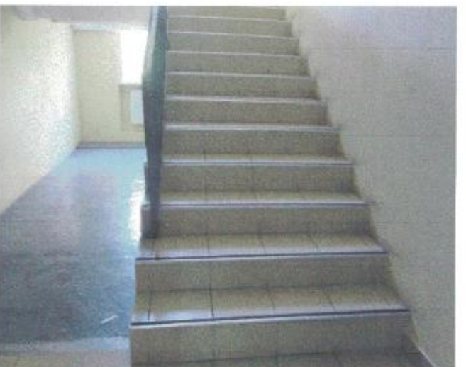
Фото №12 – Внутренние лестницы
