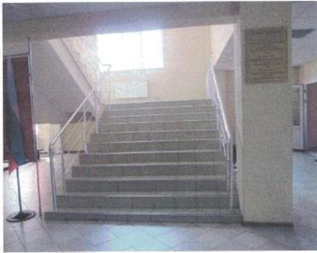
Фото №13 – Внутренние лестницы
