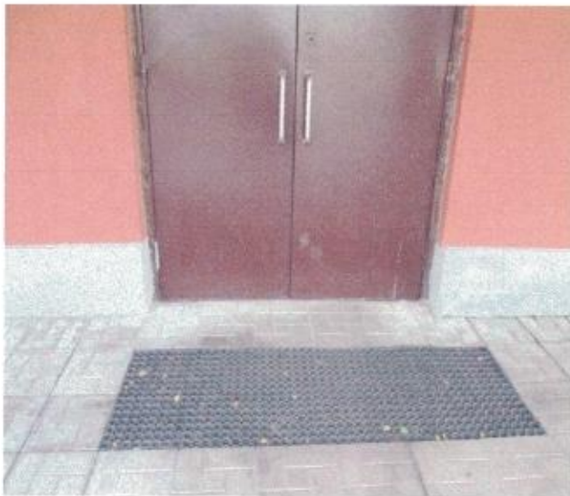
Фото №7 – Наружная входная дверь
