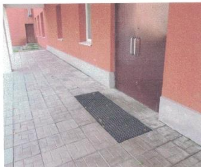
Фото №6 – Входная площадка главного входа
