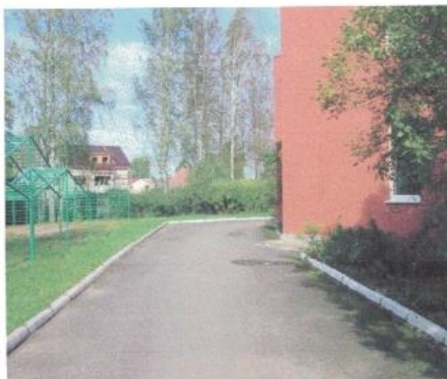
Фото №3 –Вход на прилегающую территорию
